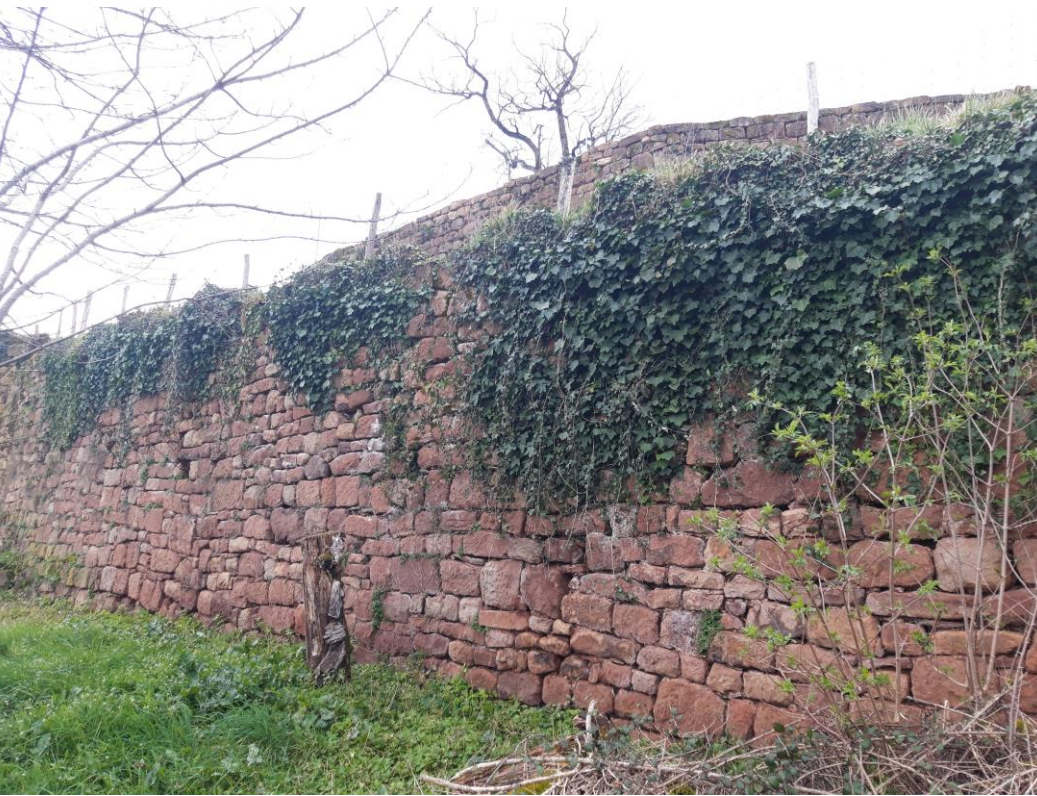
Arases rampe d'accès (18 000€)
