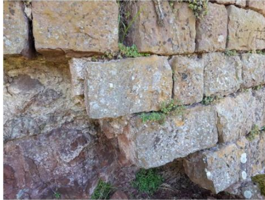
Parement externe et blocage intérieur
