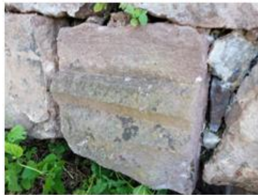
Pierre de réemploi dans une partie (re)construite au XX e siècle
