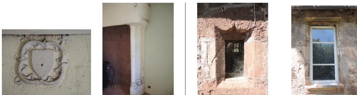
Cheminée sculptée et encadrements de fenêtre dans une maison de Grandsanhes
