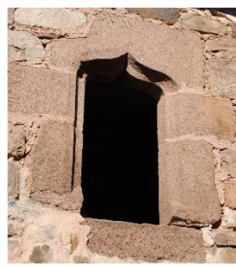
Encadrement de fenêtre dans une grange à Labro
